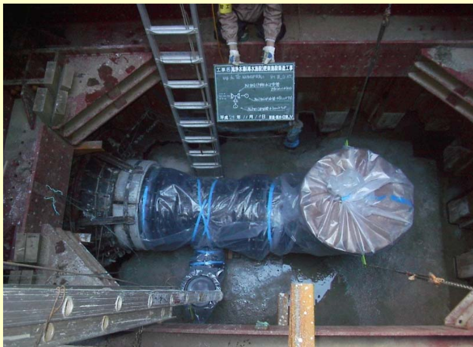
φ800mm導水管布設状況(旭浄水場側)
