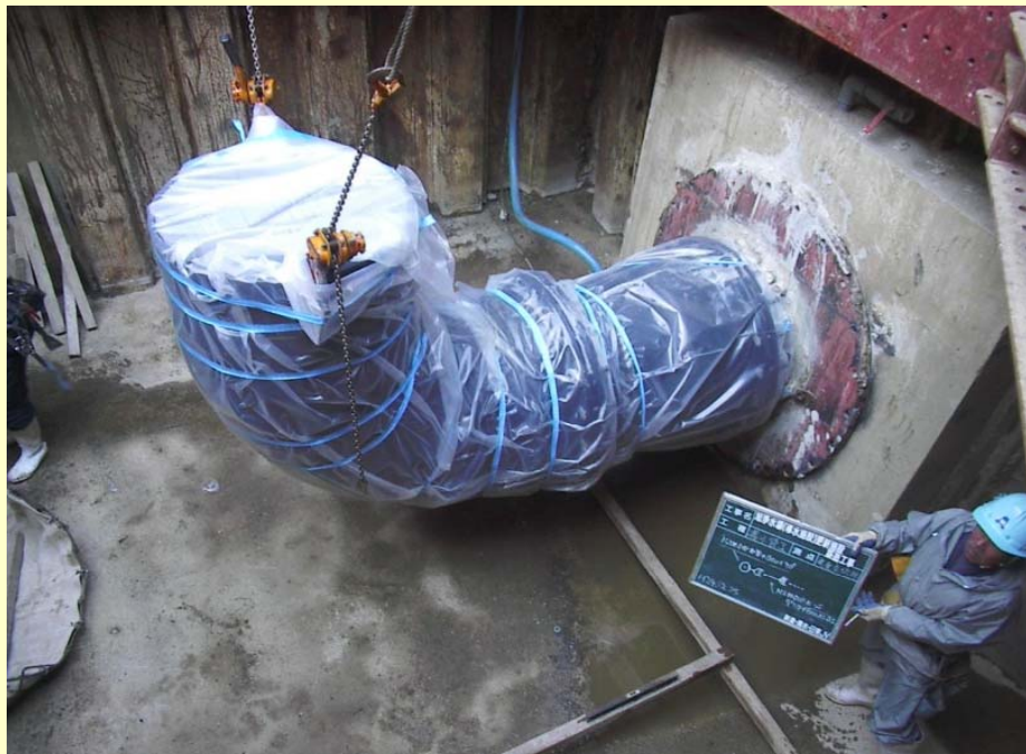
φ800mm導水管布設状況(鏡川取水所側)
