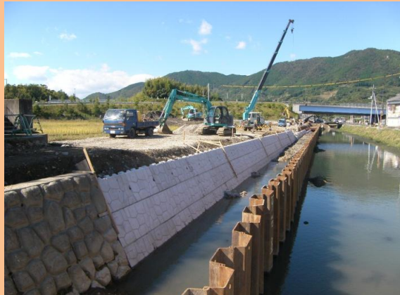
鋼矢板内部の状況（11月1日撮影）
