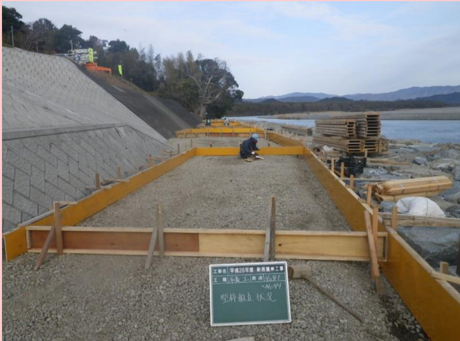
型枠組立完了
