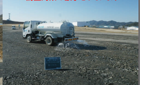
防塵対策の散水をしています
