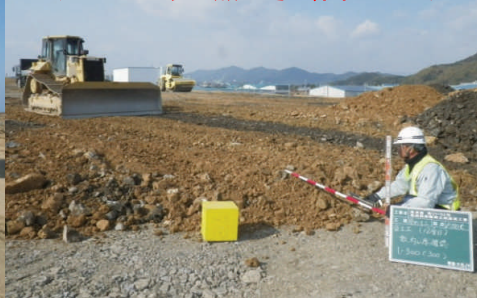
運んだ土砂を敷き均し、固めています
