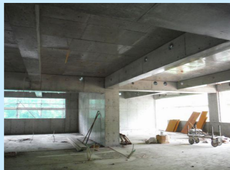
2階：型枠解体
